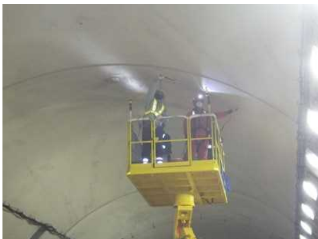
トンネル点検
