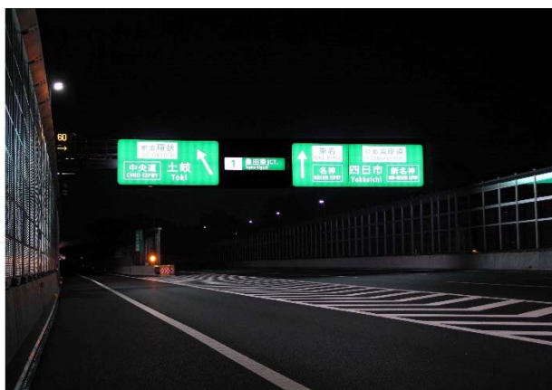
LED 照明を採用した標識
