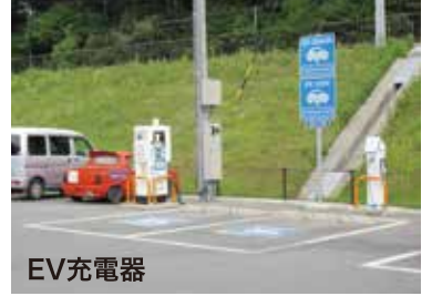
EV充電器 急速充電1台、普通充電1台を設置
