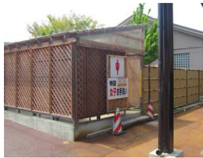
【特設トイレの設置】
