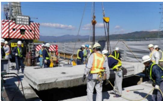
RC 床版撤去状況
