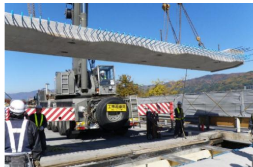
PC 床版架設状況
