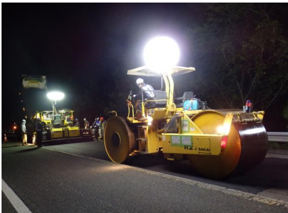
《舗装補修工事》
