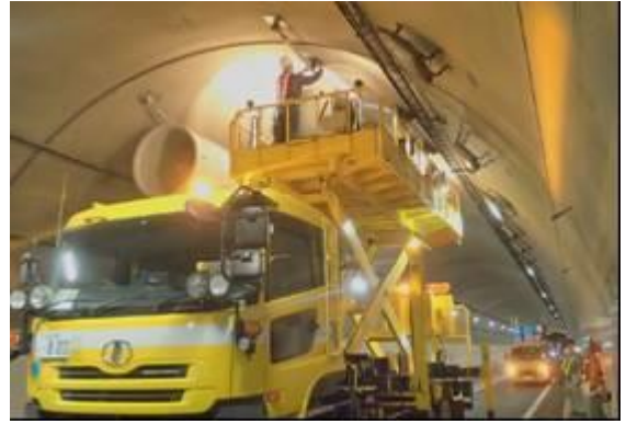
《トンネル設備の清掃・点検》
