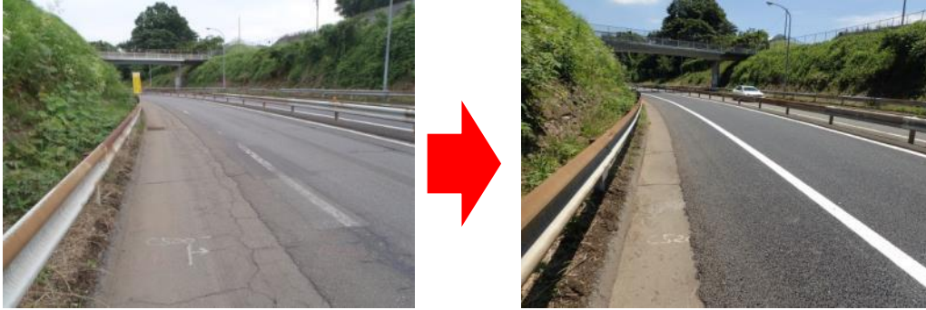
舗装補修工事の様子
