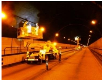
《照明設備点検 および安全対策》
