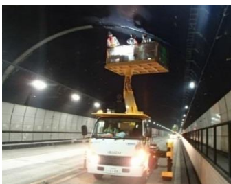
《トンネル点検》
