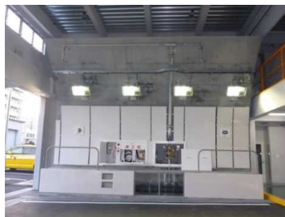
半断面トンネル
